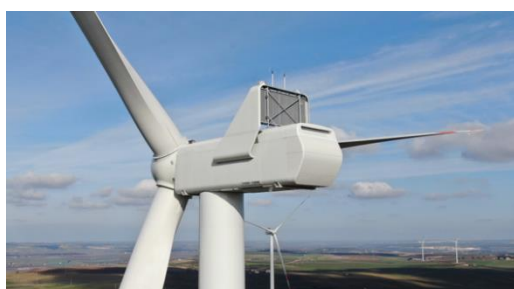
Le parc éolien de Bel Lavello est équipé de 12 éoliennes s de 3.3 MW. Le contrat de service et de maintenance prévoit d'assurer la performance optimale des éoliennes à tout moment.
