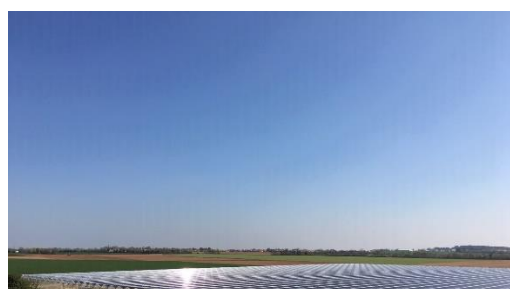
Parmi les solutions de Technique Solaire, la conception et l'installation de serres photovoltaïques optimise l'utilisation des sols et crée de la valeur pour les agriculteurs et les parties prenantes.
